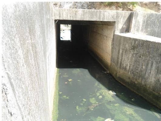
Canal de esgoto sanitário no formato de um paralelepípedo de base quadrada
