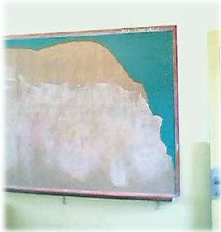
Figura 4: Lousa destruída na sala de aula
