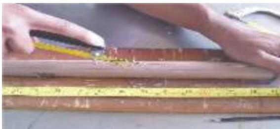
**4.** Uma vez realizado os dois cortes e retirada a tira, dar acabamento com a lixa nas superfícies cortadas e arredondar, com lima redonda, as extremidades do rasgo, levando para a largura original da placa alveolar, de 61,5 cm. Em seguida limpar com álcool.
