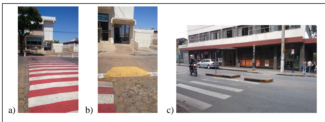
Figura 1 – Faixa de pedestre e rebaixamento de calçada em frente às Bibliotecas Públicas: a e b) Maria de Freitas de Piumhi, MG. c) Ataliba Lago de Divinópolis, MG.
