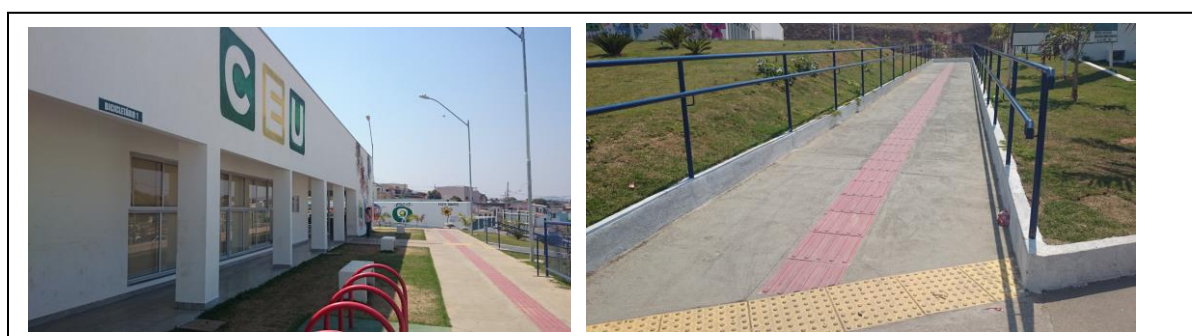
Figura 2 – Sinalizações táteis e direcionais delineando a calçada até a porta de entrada da Biblioteca Pública do Centro de Educação e Artes Unificado (CEU) – Campo Belo, MG.
