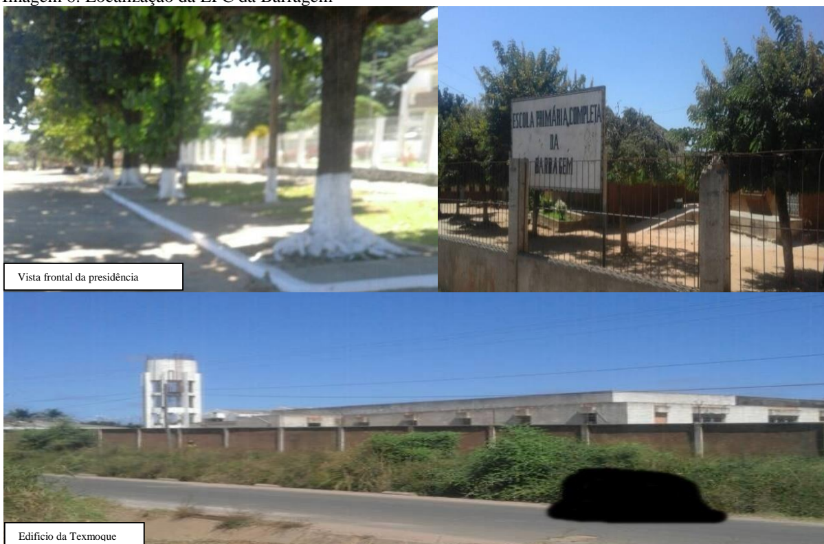
Imagem 6: Localização da EPC da Barragem
