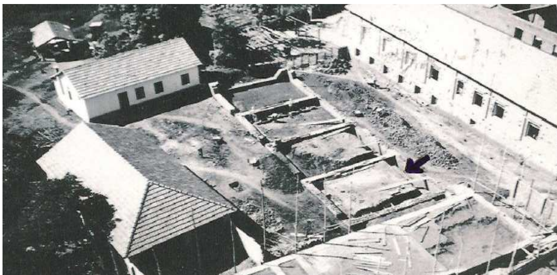
FIGURA 4. Início da construção do Colégio Nossa Senhora das Graças, 1950. Da esquerda para a direita, veem-se indícios da construção do colégio, a exemplo do alicerce. Ao lado, a edificação do prédio do educandário Sagrada Família, outro estabelecimento escolar confessional privado, já quase construído, também de grande proporção.
