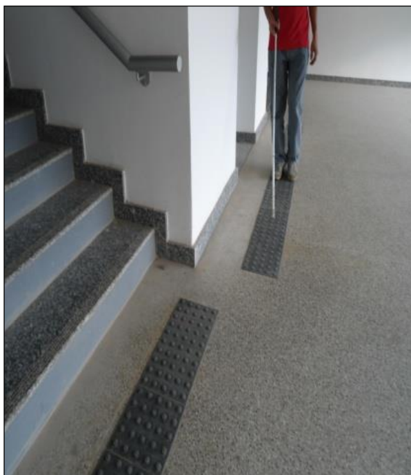
Figura7 – Pista tátil do prédio da universidade no pavilhão de aula IV
