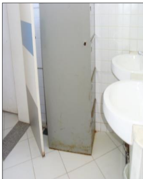
Figura 2 – Imagem do banheiro adaptado da universidade no pavilhão de aula IV
