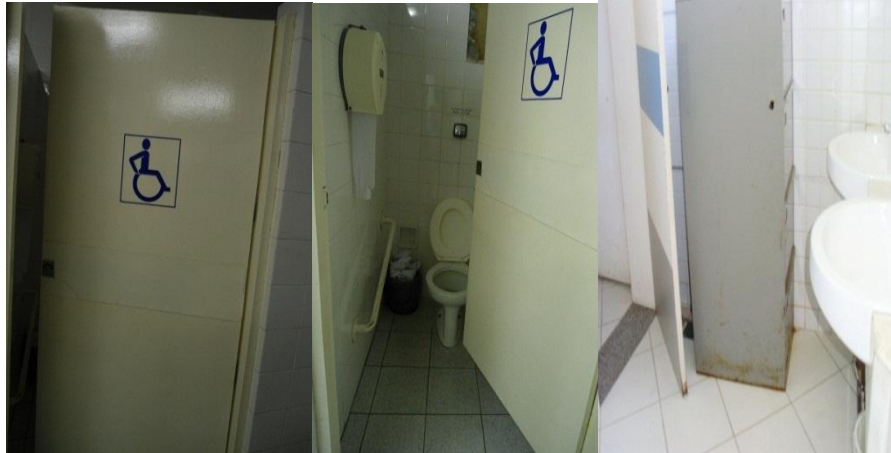
FIGURA 1 – Imagens do banheiro adaptado do pavilhão de aula IV
