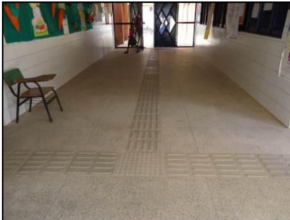
Figura 4.7 – Piso tátil na recepção
