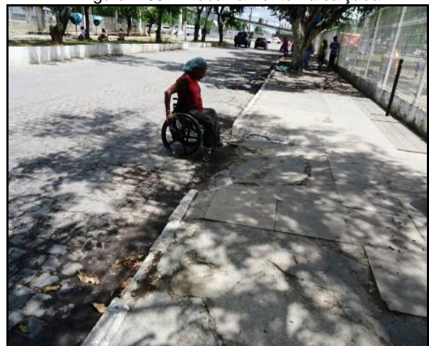
Figura 4.68 – Rebaixamento na calçada
