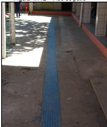
Figura 4.112 – Piso do pátio
