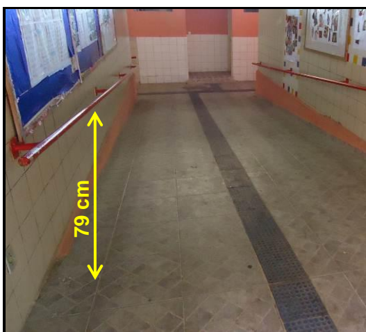
Figura 4.115 – Corrimão da rampa
