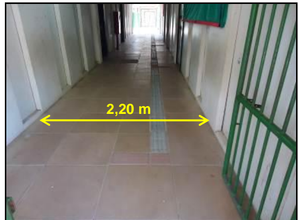
Figura 4.72 – Corredor central – pav. Térreo
