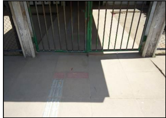
Figura 4.46 – Piso tátil no portão de entrada
