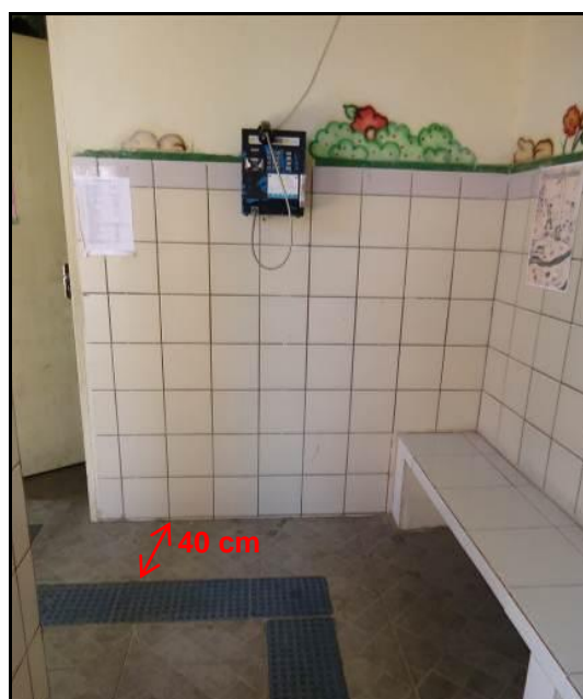
Figura 4.94 – Piso tátil na rampa
