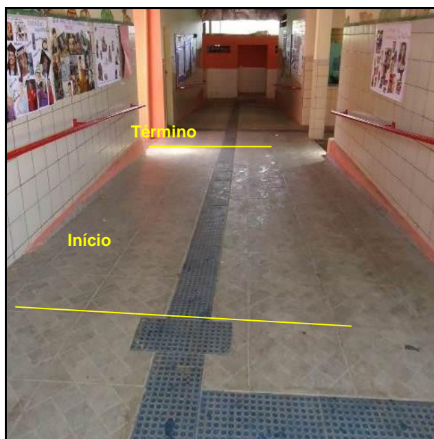
Figura 4.93 – Piso tátil na rampa
