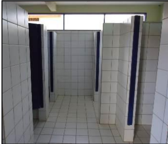
Figura 4.27 – Circulação entre os boxes do banheiro
