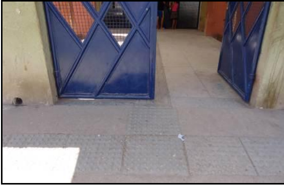
Figura 4.3 – Piso tátil na entrada da escola
