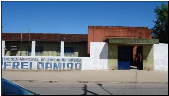
Figura 4.23 – Acesso principal - escola Frei Damião
