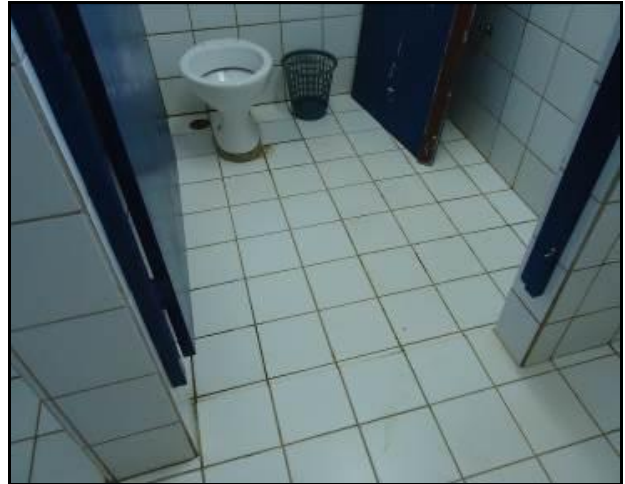
Figura 4.28 – Vão da porta boxe banheiro acessível
