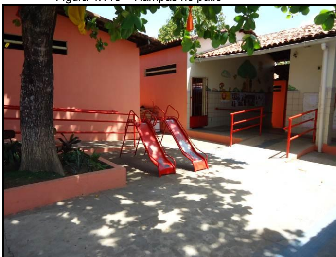
Figura 4.113 – Rampas no pátio
