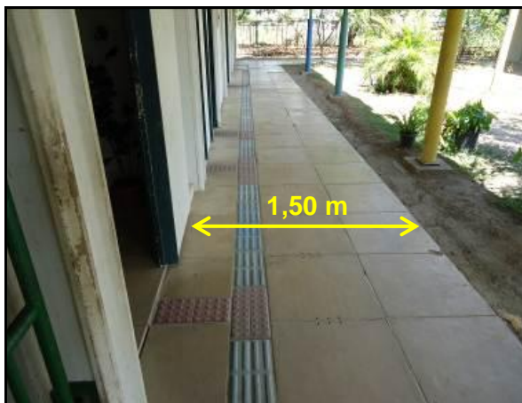
Figura 4.71 – Corredor lateral – pav. Térreo
