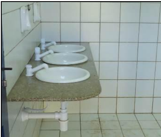
Figura 4.36 – Torneira tipo bola no lavatório
