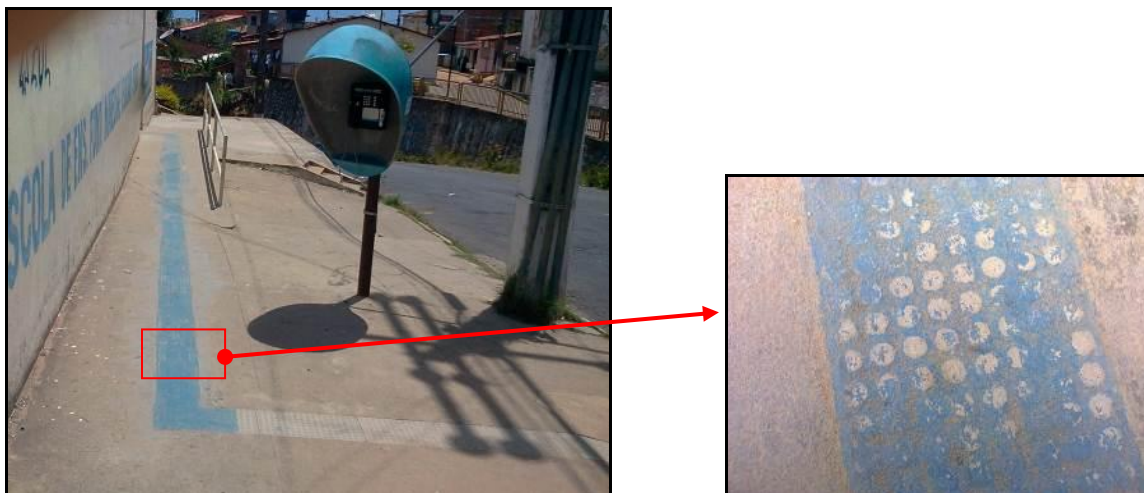
Figura 4.90 – Piso tátil na calçada
