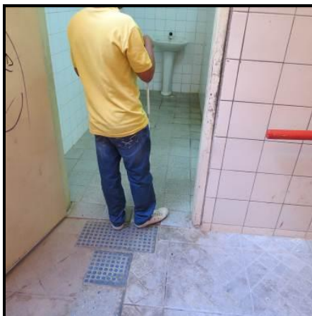
Figura 5.17 – Banheiro masculino (Ponto D na planta baixa das rotas).
