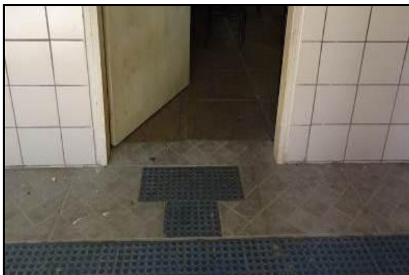
Figura 4.95 – Piso tátil na porta da sala
