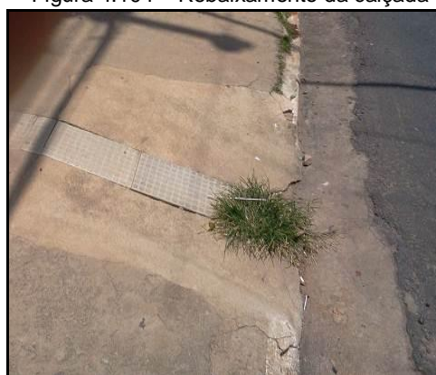
Figura 4.104 – Rebaixamento da calçada
