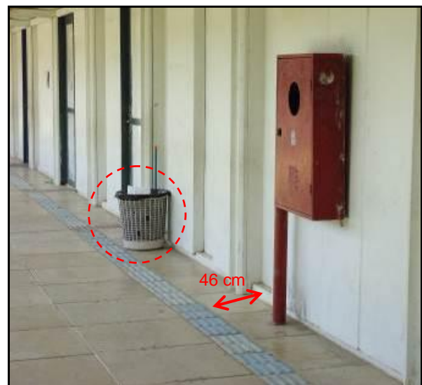
Figura 4.54 – Hidrante suspenso
