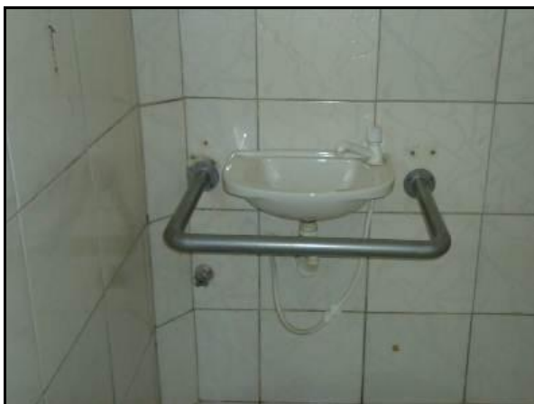
Figura 4.84 – Lavatório sanitário acessível
