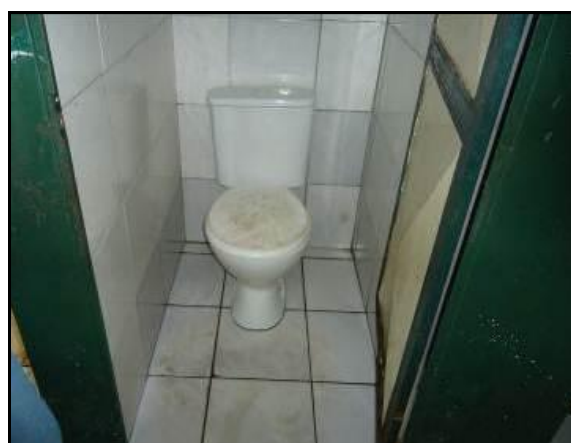
Figura 4.76 – Boxe banheiro comum
