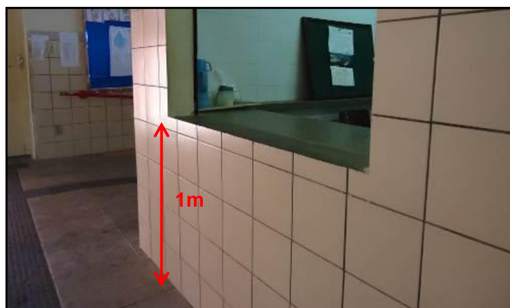
Figura 4.119 – Balcão da cantina.
