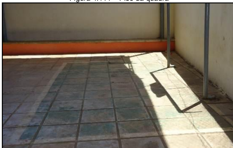
Figura 4.111 – Piso da quadra
