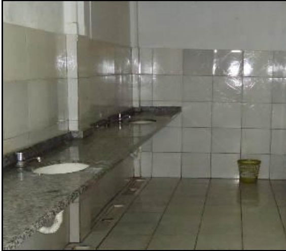
Figura 4.59 – Banheiro Ensino Fundamental
