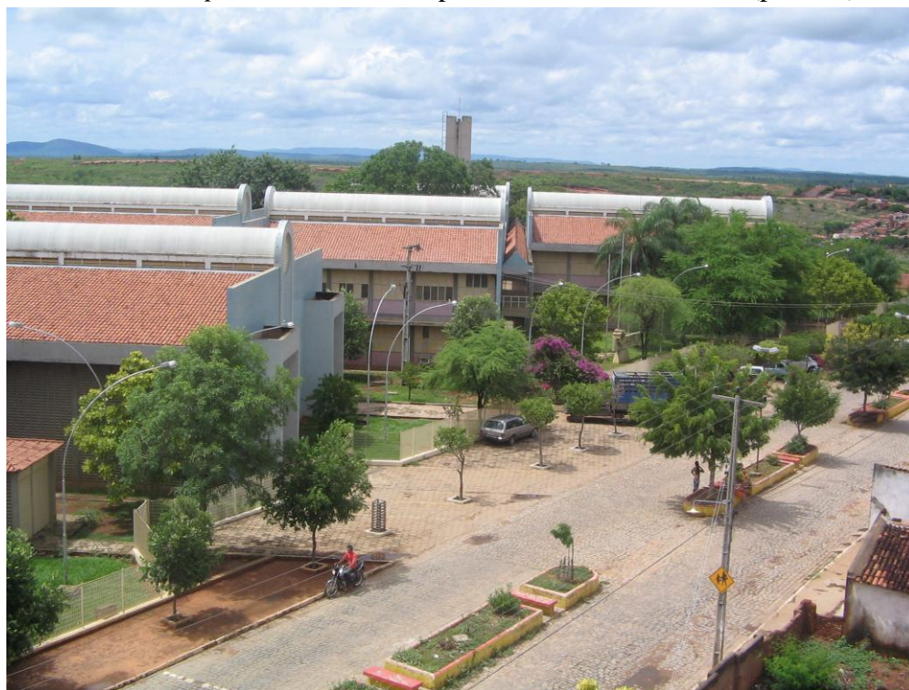
FOTO 8 IFCE – campus de Cedro: vista parcial blocos G, B, A e F (por trás)
