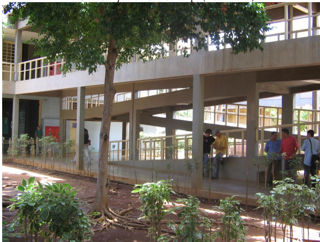
FOTO 12 IFCE – campus de Cedro: rampa (vista lateral)
