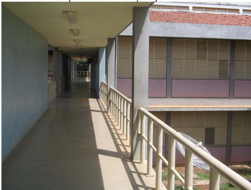
FOTO 15 IFCE – campus de Cedro: circulação superior entre os blocos
