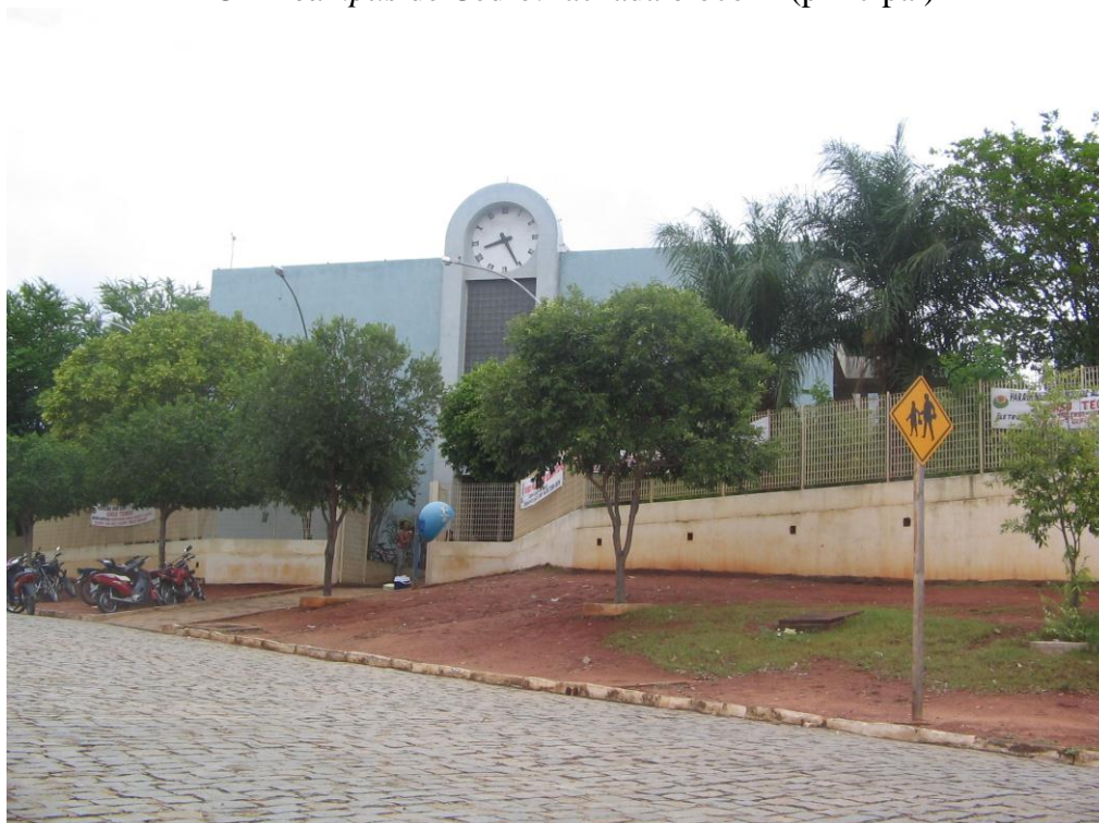
FOTO 5 IFCE – campus de Cedro: fachada bloco A (principal)
