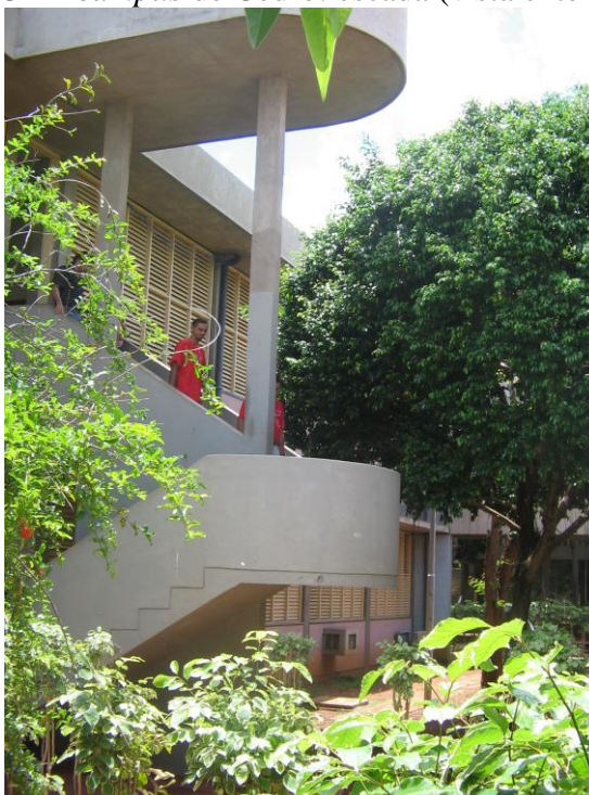
FOTO 9 IFCE – campus de Cedro: escada (vista externa)
